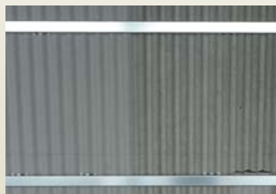
キャッチフレームの取付け
