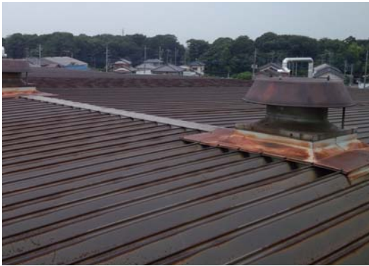
▲改修前 丸はぜ折板333
