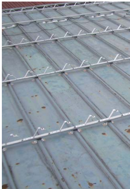
③タイトフレームの取付け
