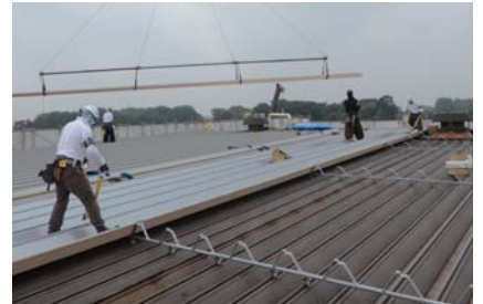
③新規屋根材の取付
