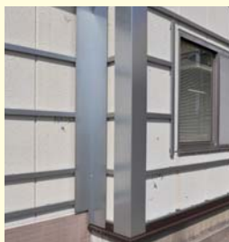
コーナー補強板Lの取付け
