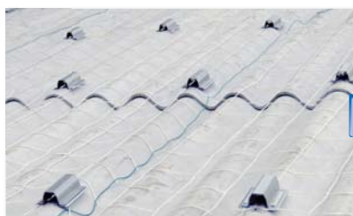
大波スレート屋根に固定金具(H25)を取付ける
