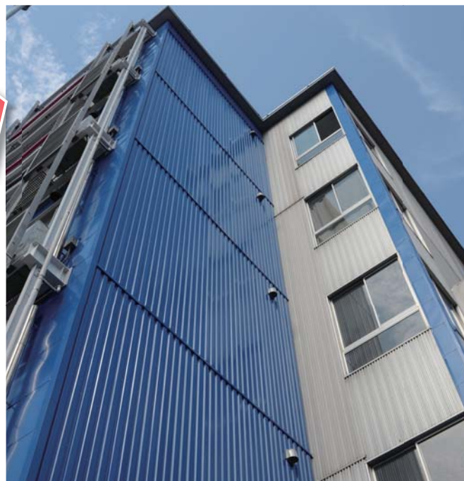
▲改修後 デプスサイディング
