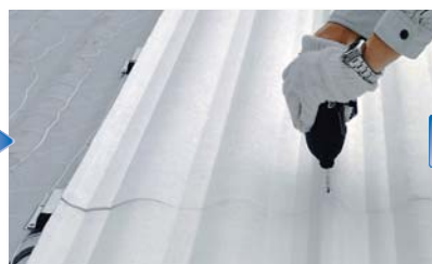
大波の形状に合わせた断熱材カルフォミクスを仮留め
